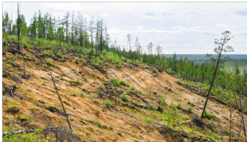
▲ Рис. 1. Оползень на участке автодороги «Амга» в 2013 г.
