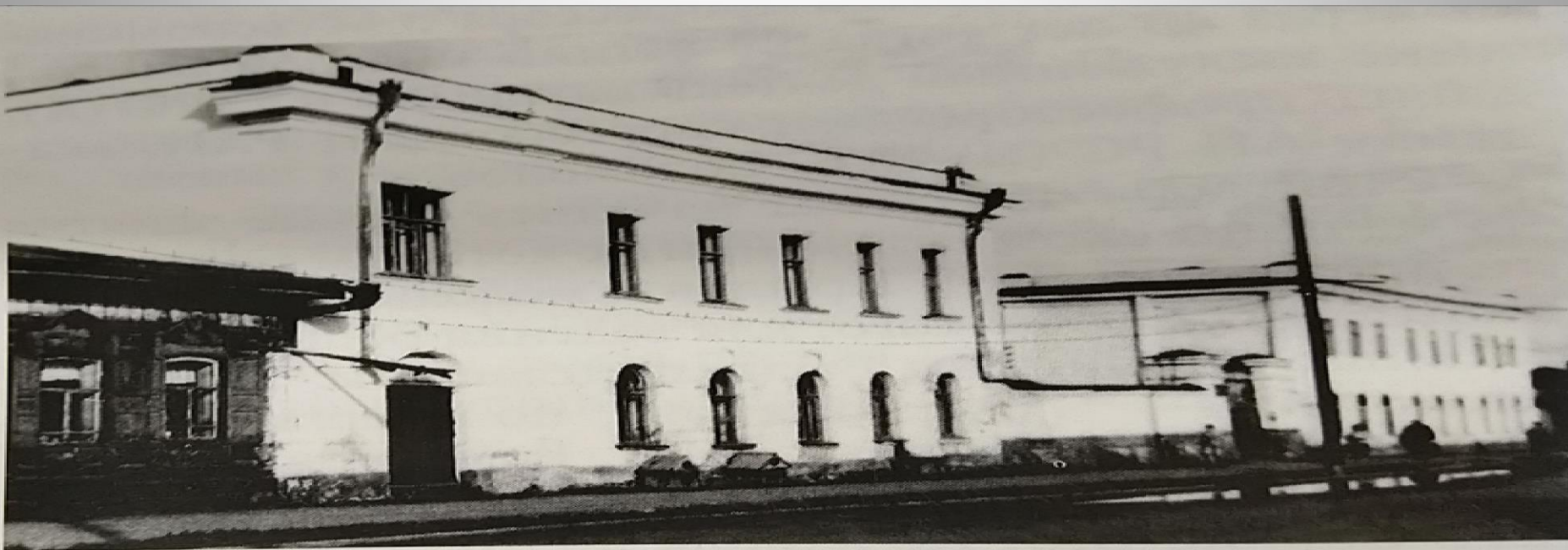
Два здания МЛФ на улице Аммосова. 1958 г.
