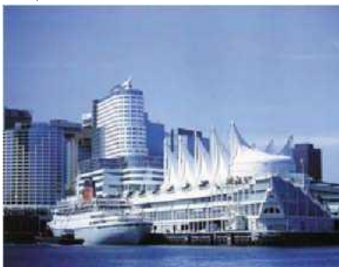
Рисунок 3. Укрытие здания Морского порта, Ванкувер, Канада
