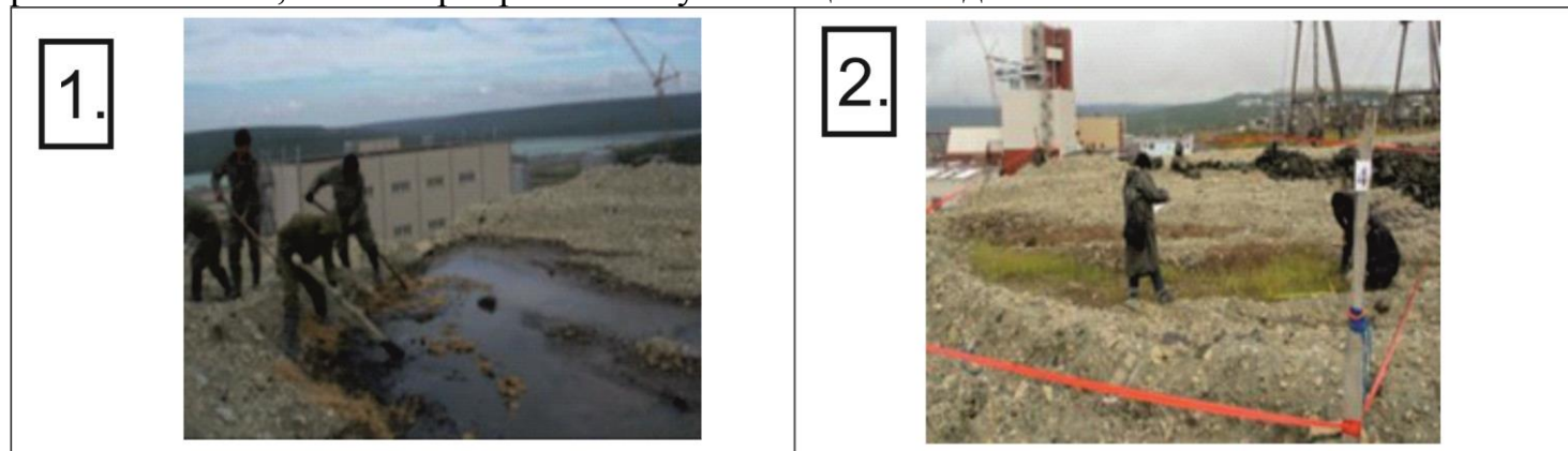
Рис. 11. Стадии работ по использованию отходов КОС для рекультивации 1.- 2010 год (подготовка поверхности, посев семян); 2. - 2012 год (оценка результатов).
