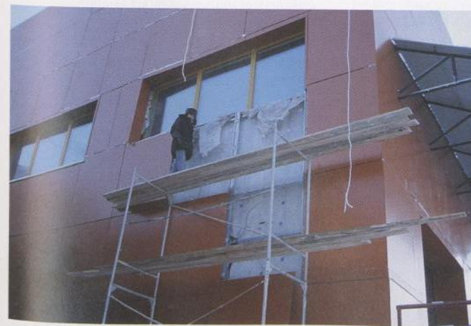
Фото 1. Корпус технических факультетов Якутского госуниверситета
