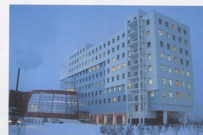
Фото 2. Общий вид экспериментального участка фасада
