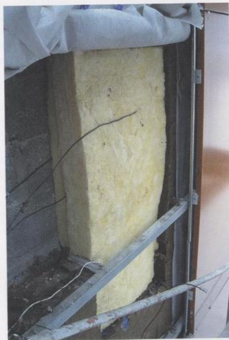
Фото 3. Расположение температурных датчиков между слоями плит из стекловолокна
