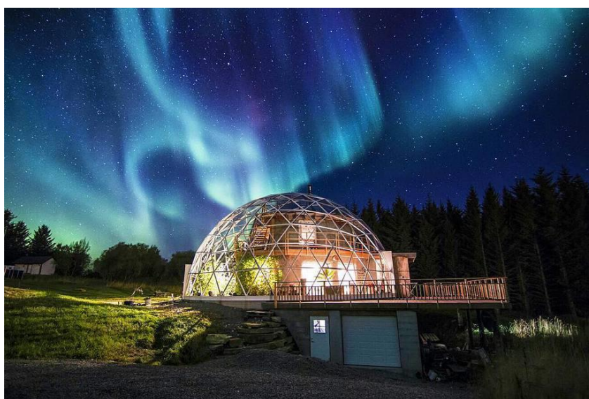
Рисунок 2. Пример строительства купола над жилым домом
